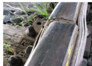
foto nr.1 – joanta din partea dreaptă a sensului de mers unde s-a produs escaladarea
