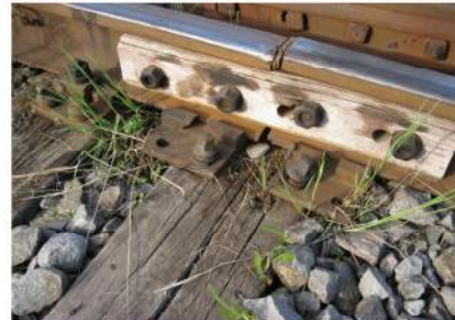
foto nr.5 - starea tehnică a joantei care a favorizat escaladarea șinei de către buza bandajului roții din partea dreaptă a sensului de mers al locomotivii
