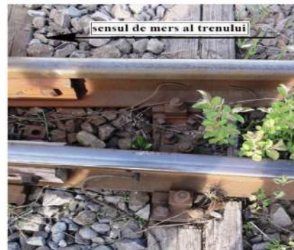
foto nr.6 - starea tehnică a traversei dinaintea joantei unde s-a produs escaladarea
