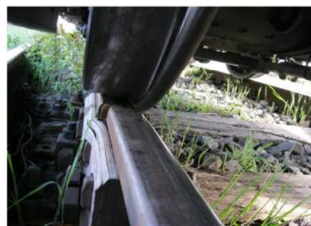
foto nr. 2 – formarea pragului lateral la trecerea materialului ruland
